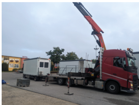
Während der Bauarbeiten kommen die Mitarbeitenden in Container-Modulbauten unter.
