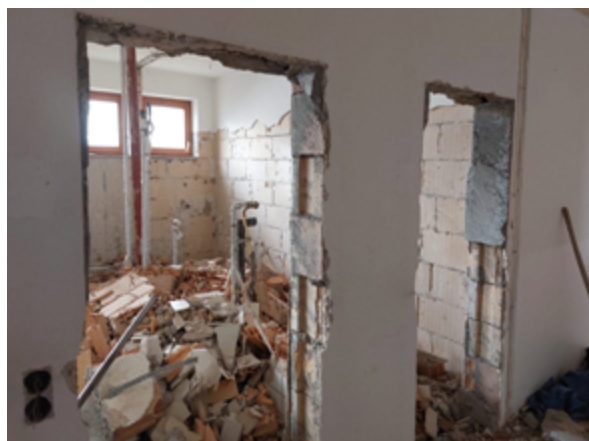
Die Rettungswache wird grundlegend saniert.
